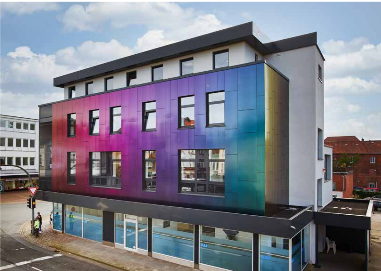
Projekt: Renovering af kontorbygning, Nienburg, Tyskland
